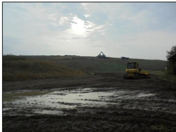
Abb. 4: Durch Rekultivierungsarbeiten entstandene Bodenschäden im Bereich der stationären Brech- und Klassieranlage..
